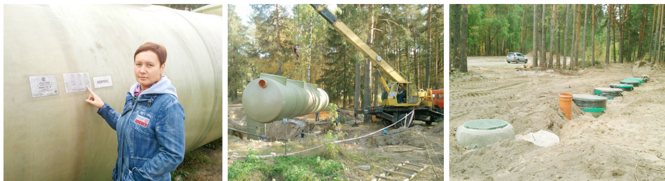
Установка очистных сооружений на выпуске № 2
