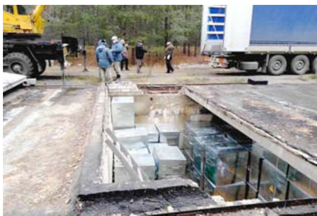
Подготовительные работы для передачи низкоактивных ТРО
