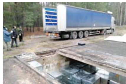
Погрузка контейнеров с ТРО
