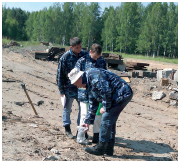
Работы на полигоне
