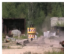
Раскалывание ж/б блока размером 80x80x150см из бетона марки 600
